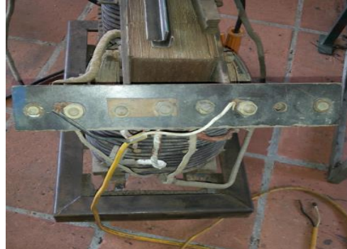
Hình 2.1.9: Cầu đấu điện cuộn sơ cấp với điện lưới
